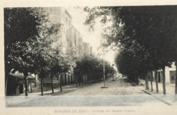
MIRANDA DE EBRU - Avenida del General Franco
